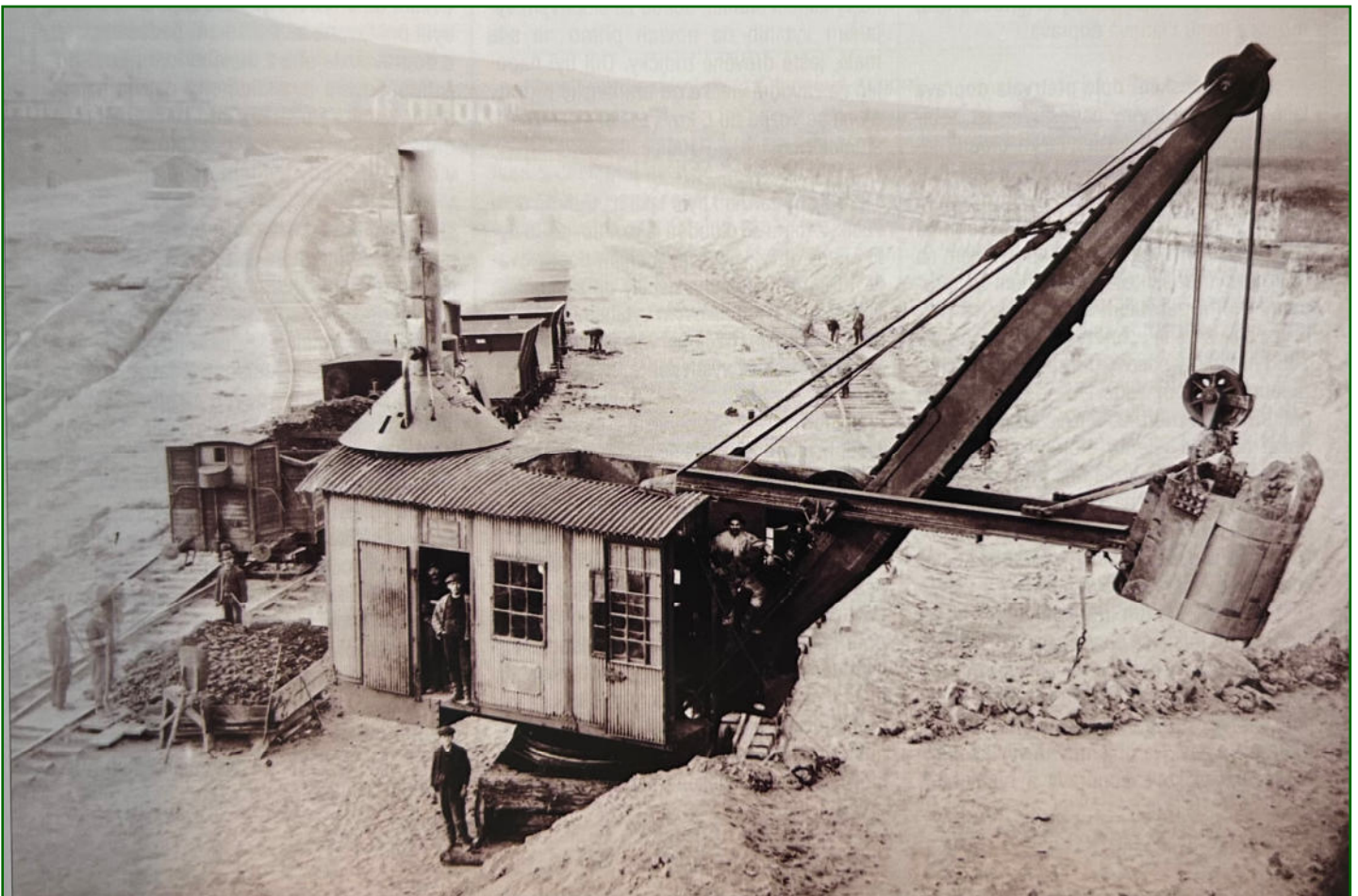
Obr. 3: Parní rýpadlo při práci ve skryvkovém řezu. Lom Svoboda, rok 1950
