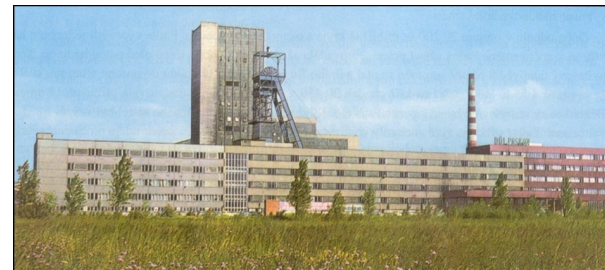
Obr. 5: Panoráma Dolu Paskov. V popředí za správní a provozní budovou se nachází ocelová věž jámy č. 2 a v pozadí betonová (skipová) těžní věž jámy č. 1 a napravo úprava uhlí.
