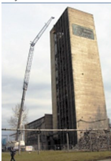
Obr. 6: Počátek likvidace skipové těžní věže Dolu Paskov (listopad 2012), která byla ukončena v červenci 2013. Podnikový archiv OKD, fond Důl Paskov.
