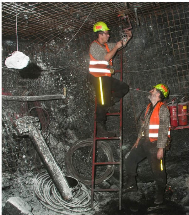
Obr. 4: Instalace úchytu pro laserové ukazovátka pro dobývací metodu CHODBA – PILÍŘ.
