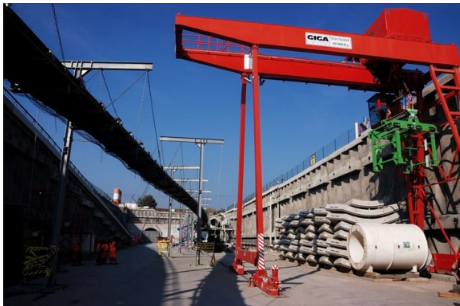
Obr. 5 Tunely Ejpvovice, Východní portál
