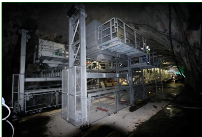
Obr. 13 Metro V.A, Vypich, přesypy dopravníku rubaniny, v pozadí S609-Tonda
