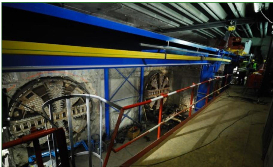
Obr. 17 Metro V.A, S609-Tonda, S610-Adéla, Stanice Dejvická
