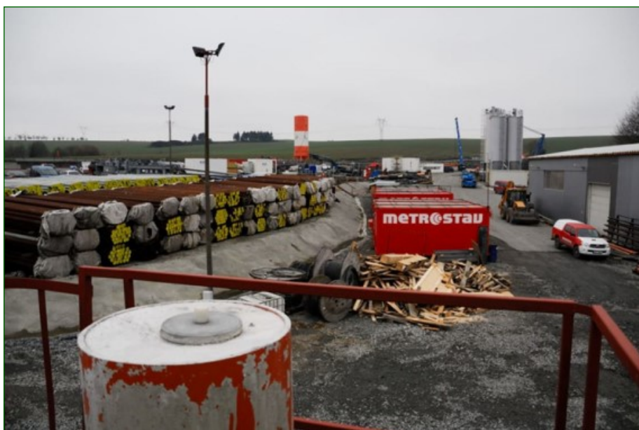
Obr. 7 Tunely Ejpvovice, ZVS pilíř na Východním portále
