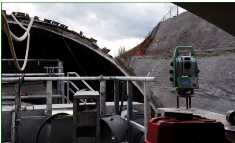
Obr. 16 Tunely Ejovice, S799-Viktorie, STT prorážkové měření
