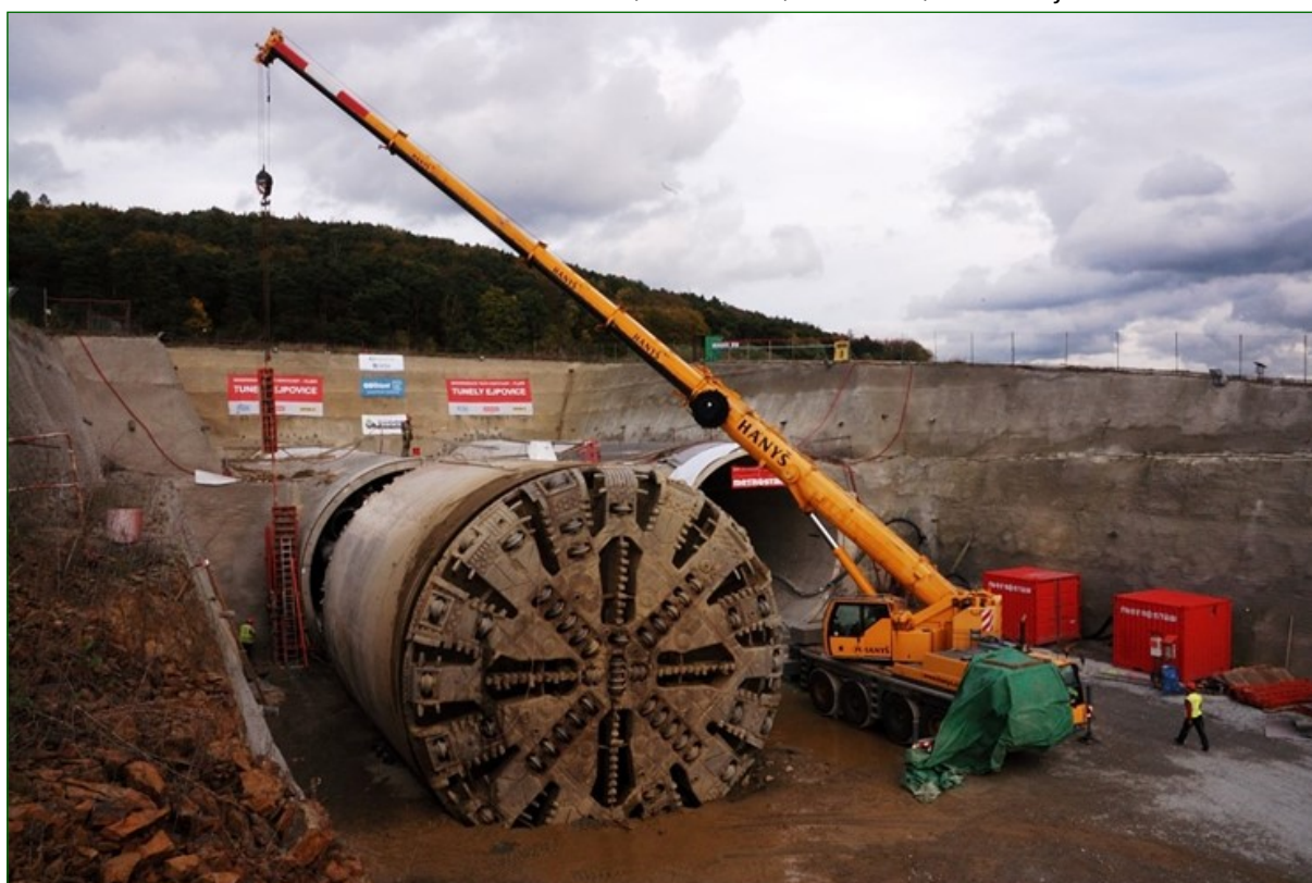
Obr. 18 Tunely Ejovice, Západní portál, S799-Viktorie po prorážce STT, JTT již hotov
